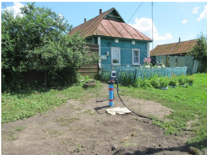
Строительство новой ЭВУ в д.Приходьково
